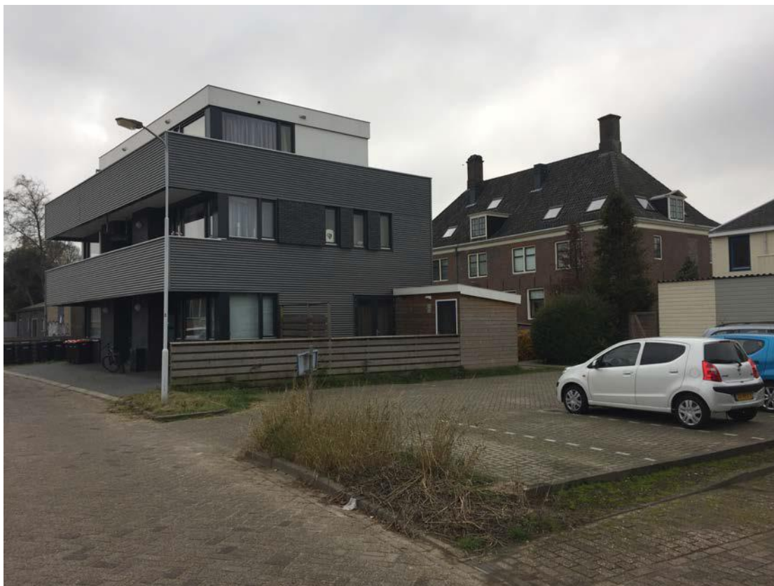
Nieuwbouw aan de Hermesstraat met de rug tegen de historische bebouwing aan de Vlusch.
