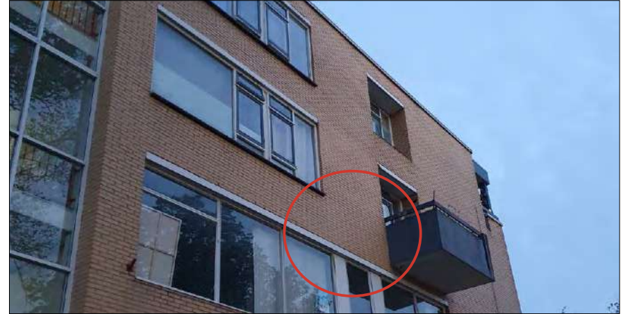
Figuur: uitvliegplek van een gewone dwergvleermuis aan de noordoostelijke kopgevel van Peperstraat 130-206.
