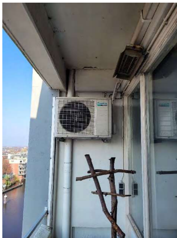
afbeelding 10: buitenunit airconditioning
