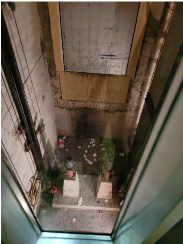
afbeelding 2: huidige liftdeuren in liftschacht
