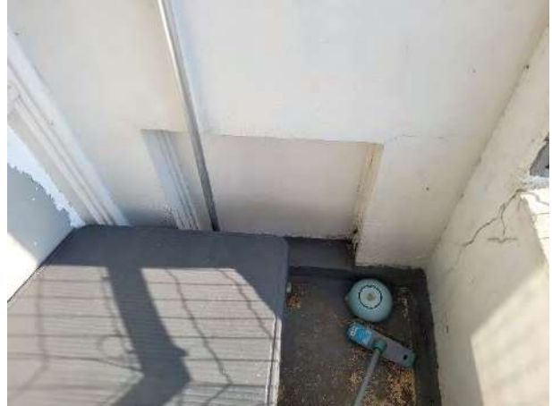
afbeelding 23: buitenruimte zo-gevel nr. 61
