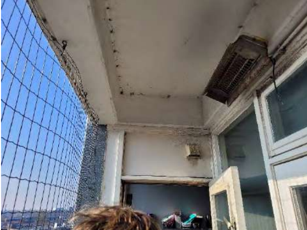
afbeelding 22: Buitenruimte zo-gevel nr. 61
