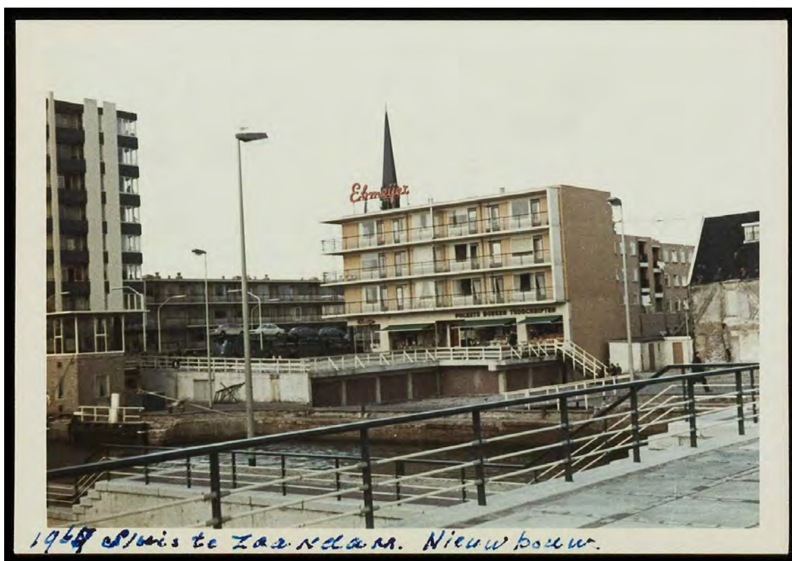
Afbeelding 6. Een foto uit 1964 geschoten in noordelijke richting vanaf de Wilhelminasluis. Op de foto is de parkeerkelder duidelijk te zien.
