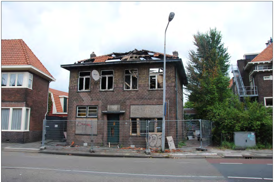
Afbeelding 9. Het afgebrande pand op de A.F. de Savornin Lohmanstraat 10 waar de boringen 12, 13 en 14 zouden worden gezet.
