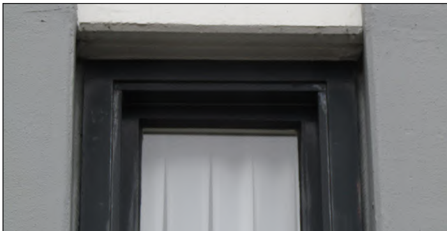
Figuur: de hoge flat aan de westzijde van het plangebied heeft geen geschikte openingen voor vleermuizen. Er zijn rond de ramen geen spleten of kieren aanwezig die als invliegopening gebruikt kunnen worden.
