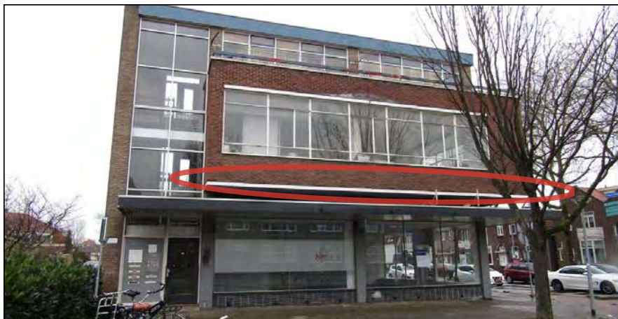
Figuur: op de foto is zichtbaar dat in de onderste rijen bakstenen open stootvoegen aanwezig zijn, welke toegang kunnen bieden tot een luchtspouw. Door in te zoomen worden de openingen beter zichtbaar.
