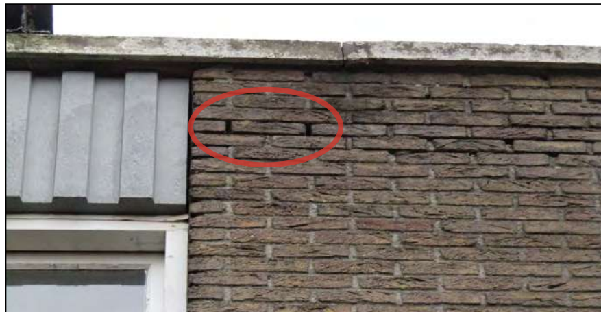
Figuur: open stootvoegen, zoals in de foto omcirkeld, bieden vaak toegang tot een luchtspouw. Hierin kunnen vleermuizen een verblijfplaats hebben.
