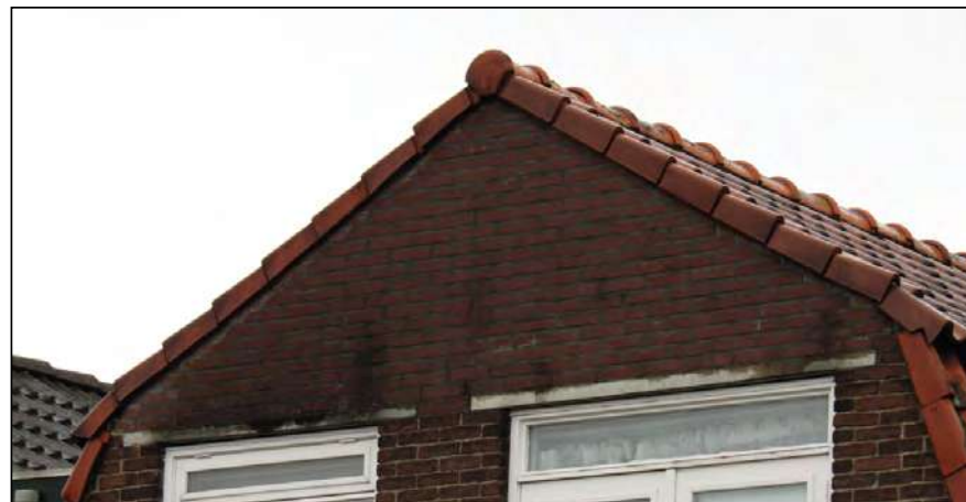
Figuur: in de directe omgeving van het plangebied zijn enkele daken aanwezig welke geschikt zijn voor gierzwaluw en huismus. De ruimtes tussen de gevel en de gevelpannen kunnen als invliegopening fungeren.
