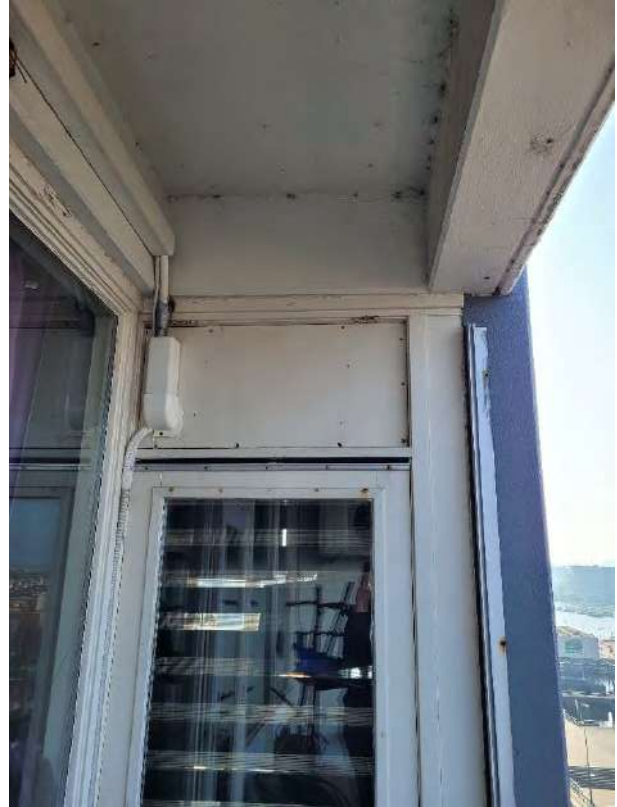
afbeelding 8: deur tussen woonkamer en buitenruimte
