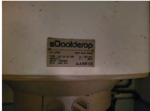
afbeelding 21: technische gegevens elektrische boiler
