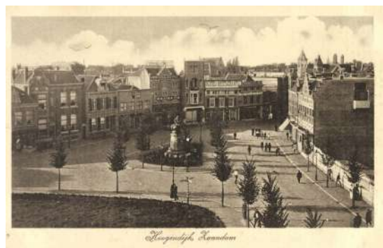
# Hogedijk zichtbaar, eerste bebouwing gereed (GAZ)
