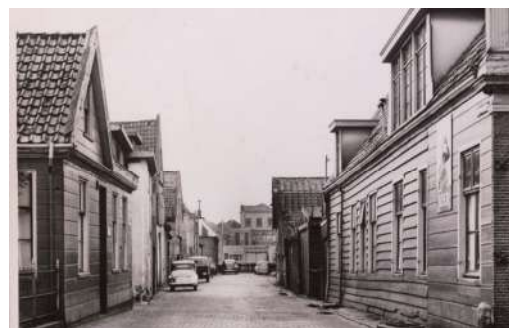
# HF Peperstraat 1954 (GAZ 21.22527)
