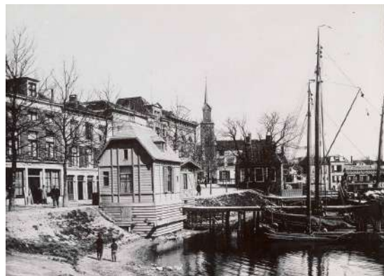
# Havenkom aan de Hogedijk (GAZ)
