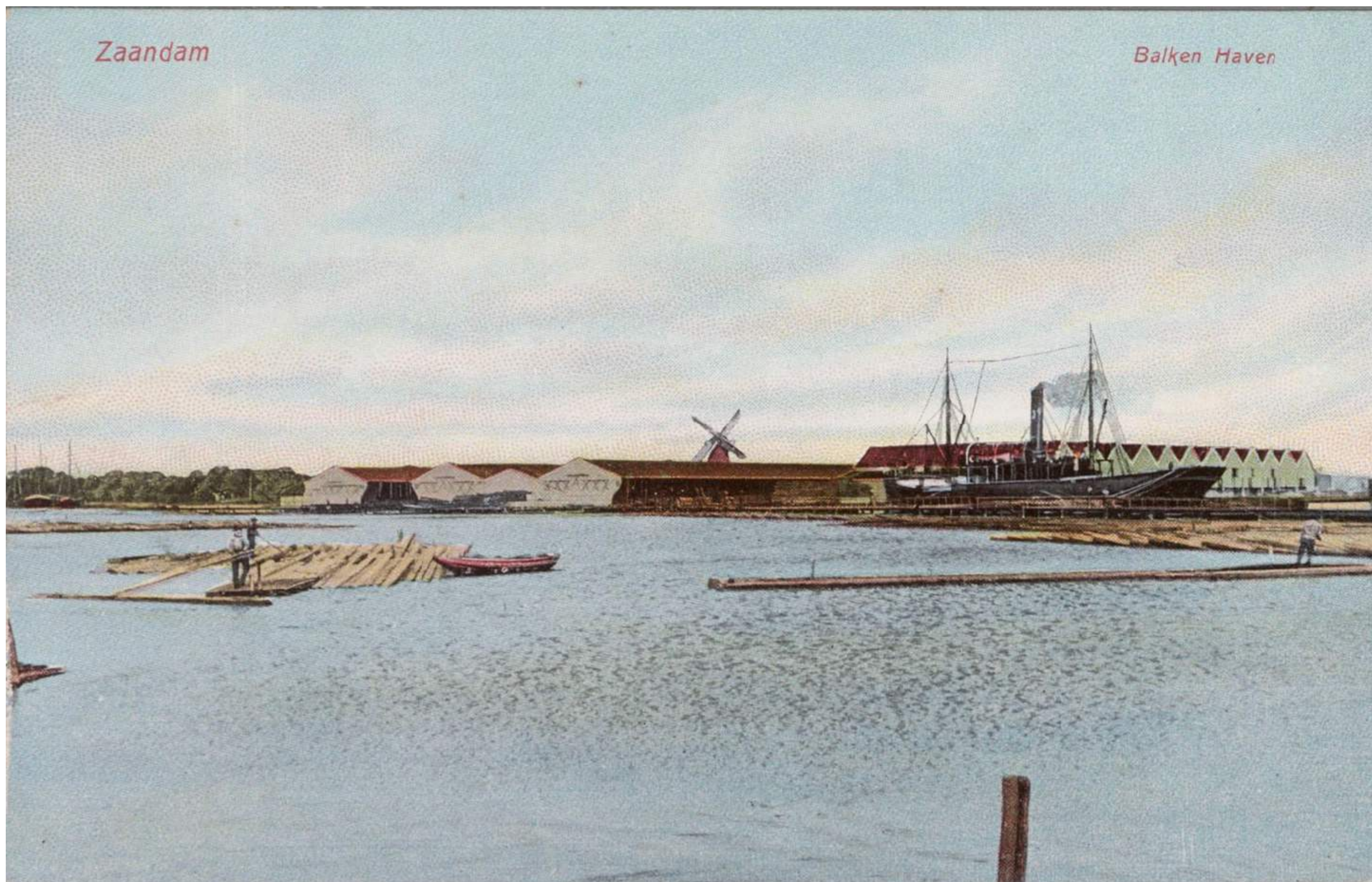
22. Het Ponteland met de houtloodsen en de zaagmolen en op de voorgrond een houtvlot, (Zaans Archief 41.05446)
