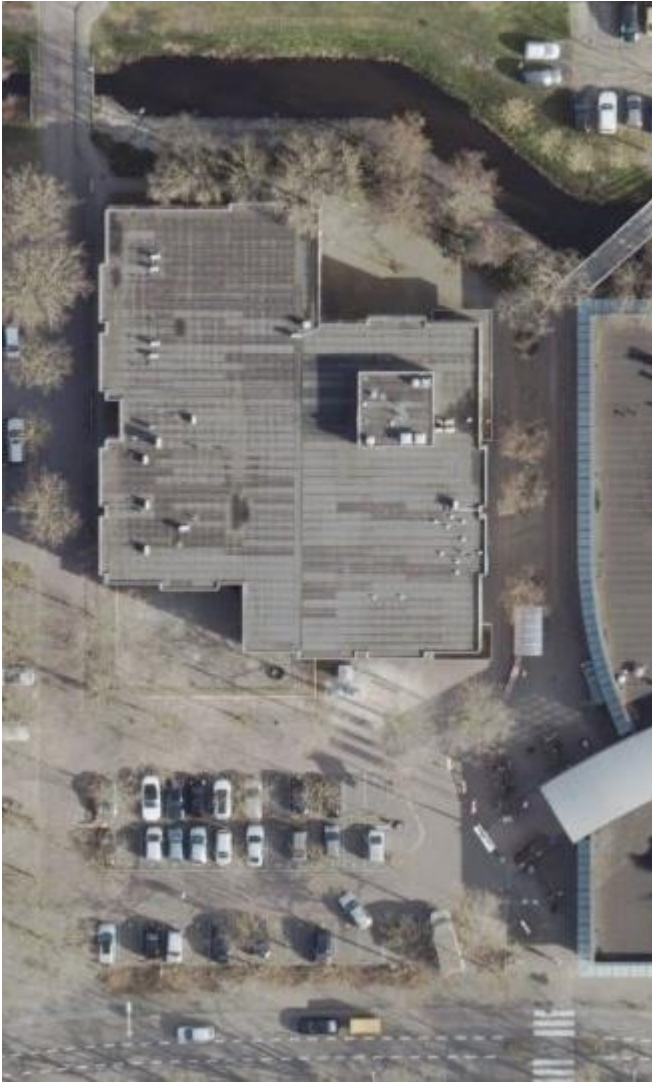
Figuur 1: luchtfoto huidige situatie
