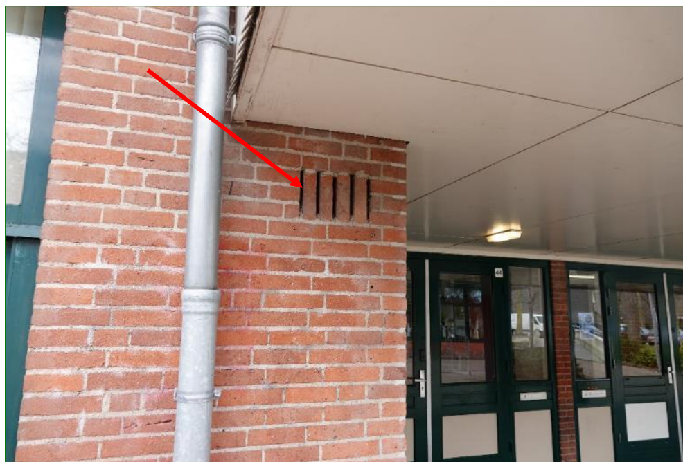
Belangrijkste invliegmogelijkheden in het gebouw.
