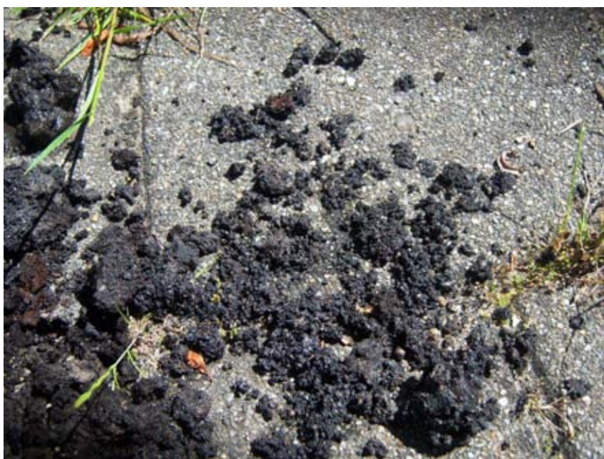
Afbeelding 9. "Sintels" zoals aangetroffen in boring 10.
