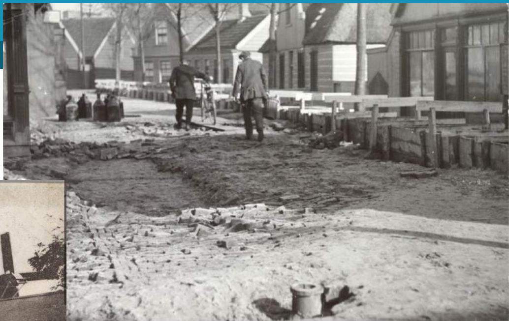
Oostzijde met gedempte wegsloot ter hoogte van nummer 374, 1916 (GAZ 41.07668)
