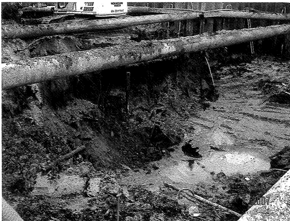
Foto 13 Impressie ontgravingsput binnen de damwand van vak 12
