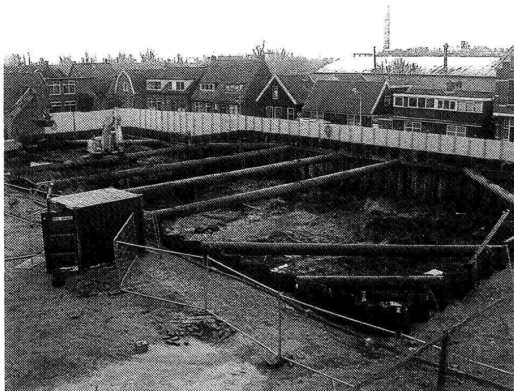
Foto 12 Overzicht op werkzaamheden binnen de damwand in vak 12
