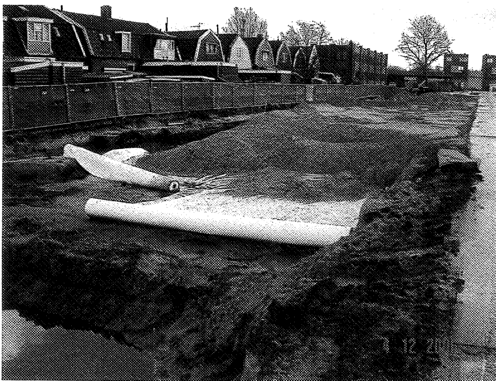
Foto 5 Aanbrengen signaleringsdoek en aanvullen vak 4
