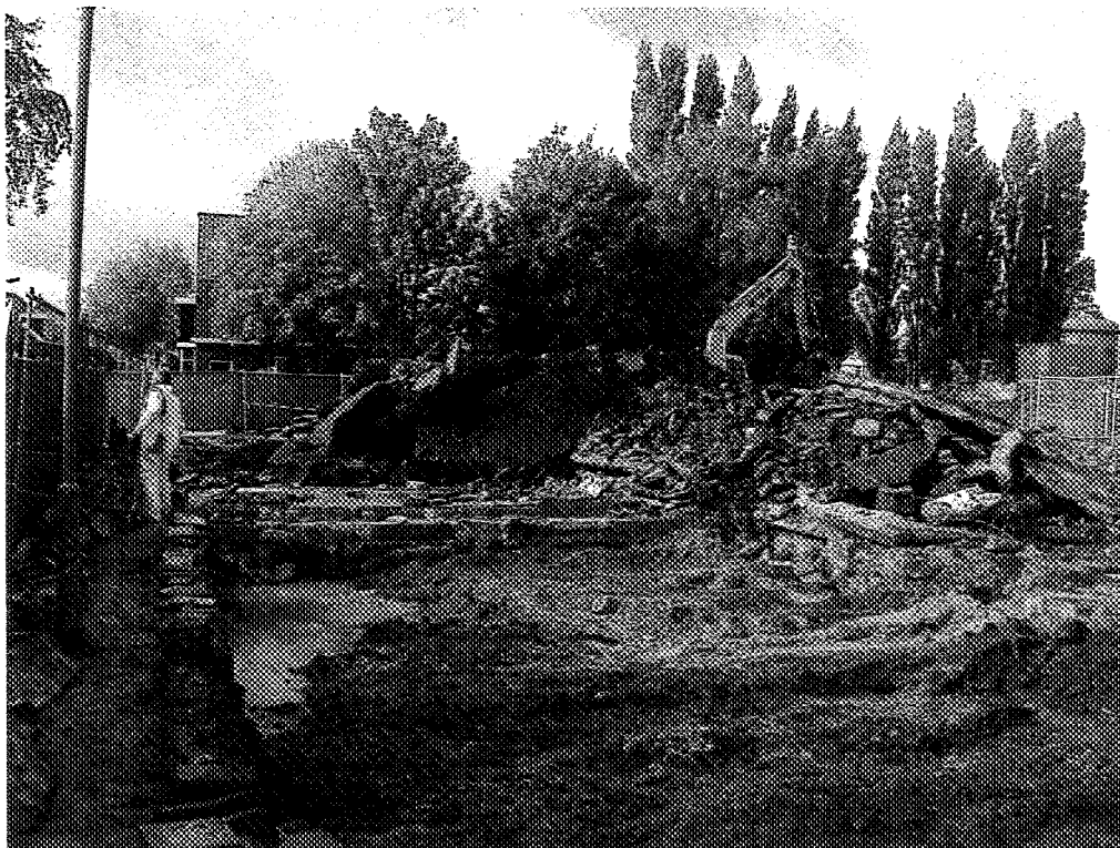
Foto 11 Verwijderen funderingsresten Groot Wever in vak 12
