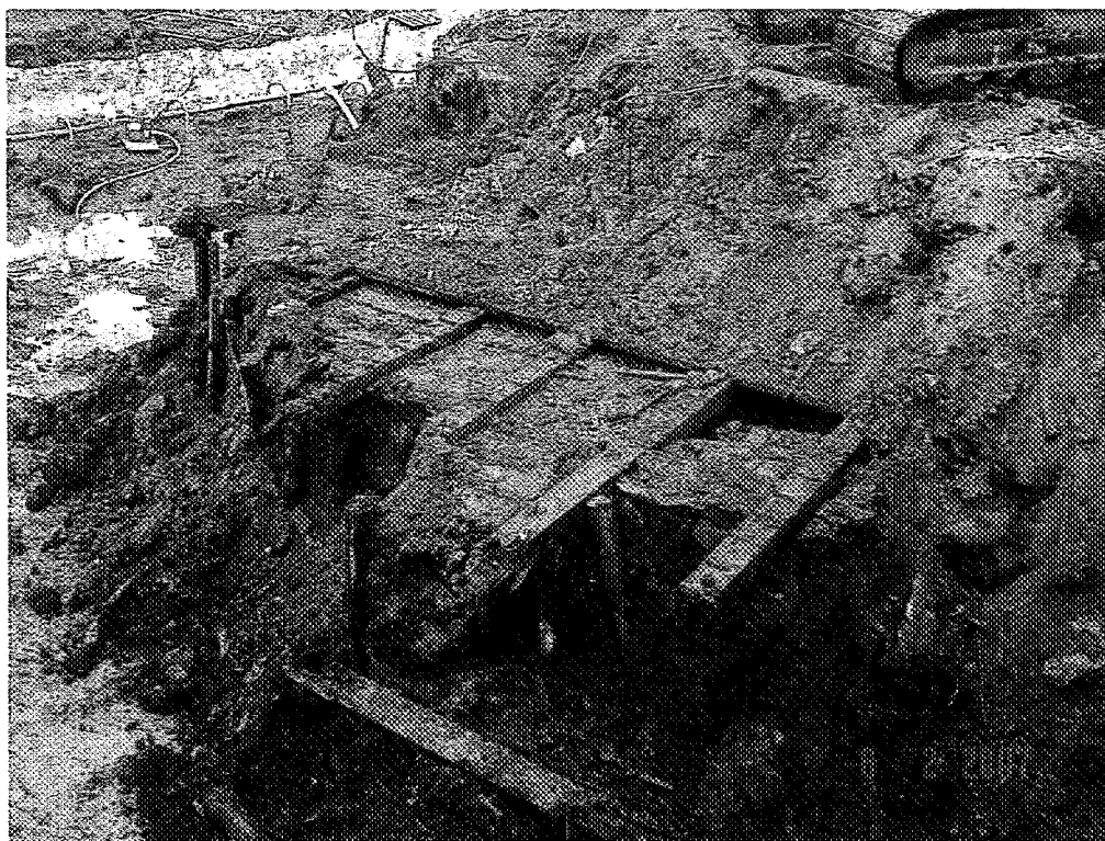
Foto 14 Impressie ontgravingsput binnen de damwand van vak 12
