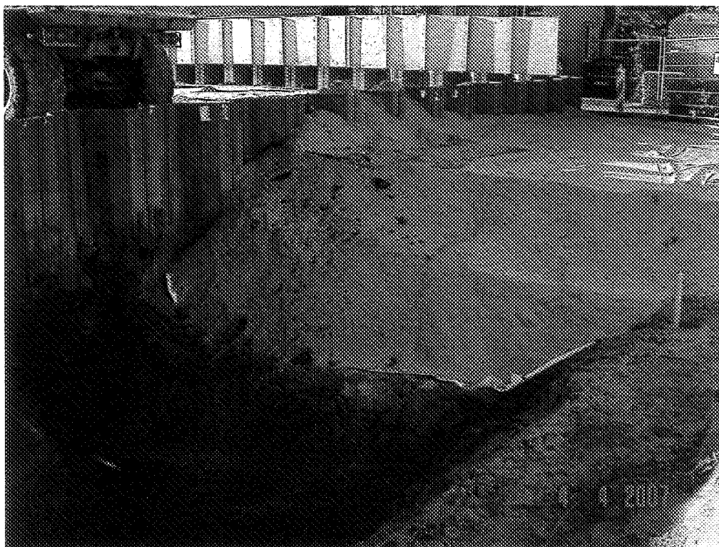
Foto 10 Aanvullen vak ten westen van de damwand
