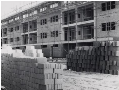
1962 Poelenburg in aanbouw (beeldbank Zaans archief 22.2097)
