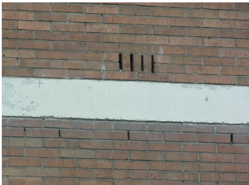
detail toegangsoeningen naar de spouw
