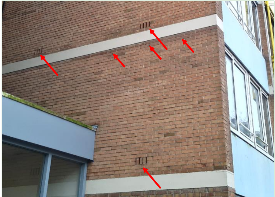
De openingen in de spouwmuren in de galerijflat (rode pijlen) geven mogelijk toegang tot voor vleermuizen geschikte achterliggende ruimtes.
