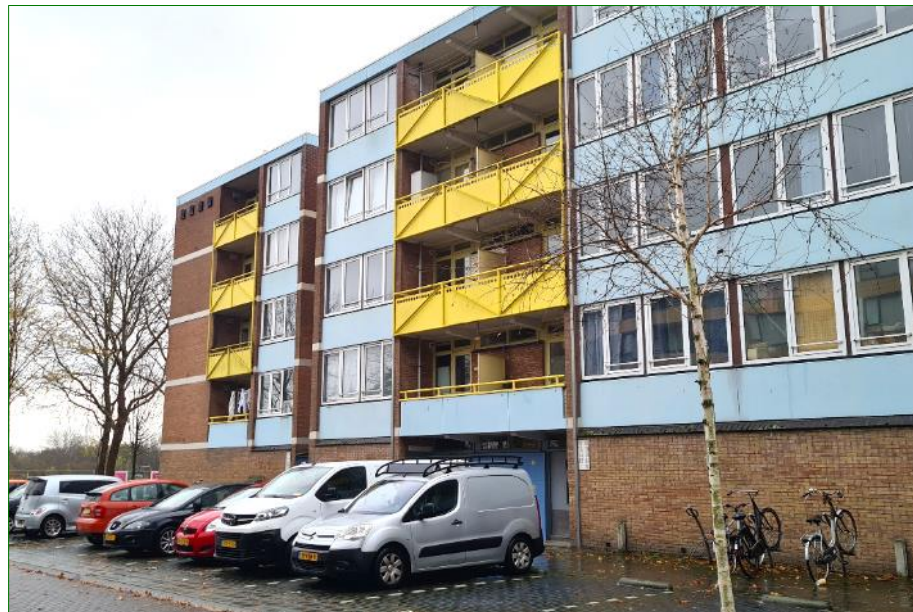
Noordgevel van de galerijflat.
