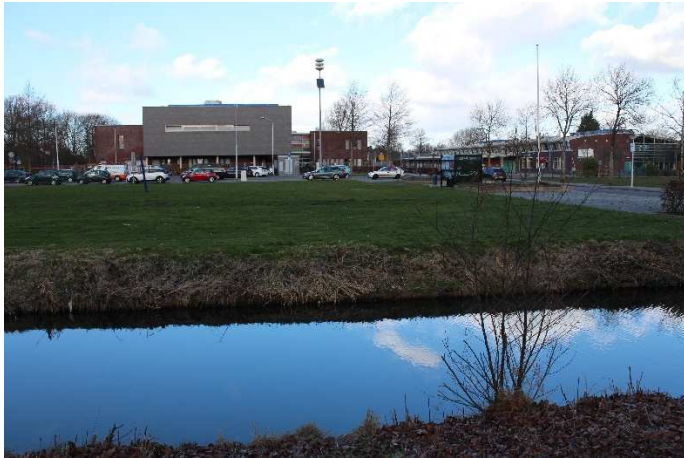
Veldje ontstaan door sloop van sporthal 'De Sprong'.
