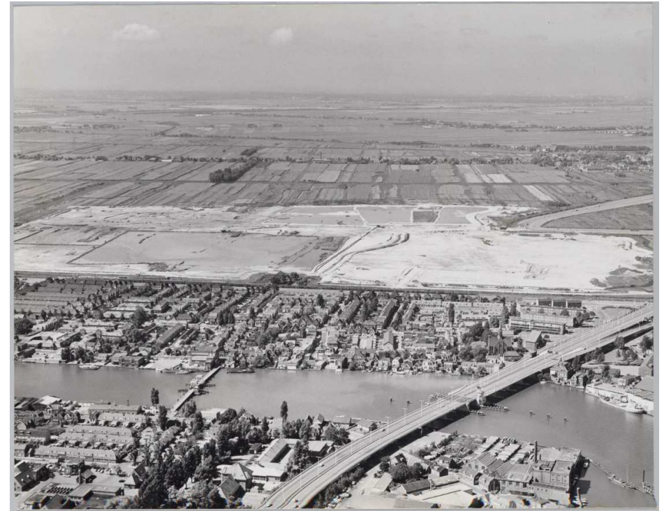
Luchtfoto van Koog aan de Zaan met op de achtergrond de wijk Westerkoog die in ontwikkeling is, datering foto 1972 (bron: Gemeentearchief Zaanstad, inventarisnummer 22.23835). Op deze foto is te zien dat de aanwezige landschapselementen (sloten) bij het bouwrijp maken van het terrein goeddeels verdwenen.
