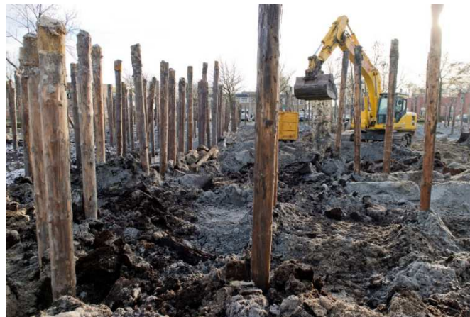
De sloop van de afgebrande sporthal 'De Sprong', foto in 2016 vervaardigd door Nathan Mandjes. De houten funderingspalen zijn uit de grond getrokken om verwijderd te worden (bron: Gemeentearchief Zaanstad, inventarisnummer 20.00320).
