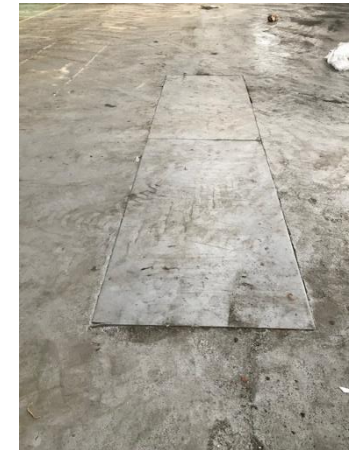
Foto 21 uitsparing in vloeistofdichte vloer fabriekshal. Niet inspecteerbaar, maar zeer waarschijnlijk met vloeistofdichte betonnen onderbak.
