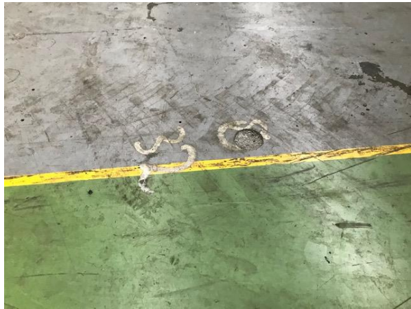
Foto 19 Boring 32 in fabriekshal uit voorgaand onderzoek.
