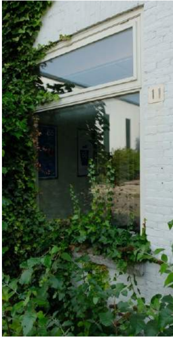
Afb. 27 (boven) - Raamkozijn eerste bouwlaag.
