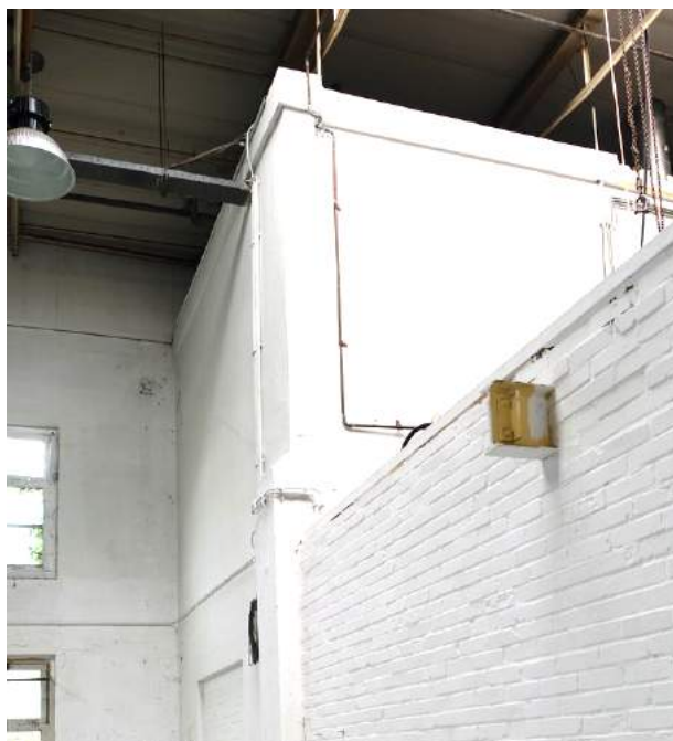
Afb. 29 (boven) - Enige bewaard gebleven, authentiek kozijn op de tweede bouwlaag.
