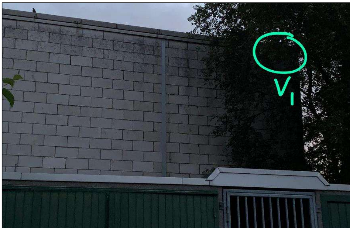
Afbeelding 2.5. Vier invliegende gewone dwergvleermuizen noordoost hoek van de binnenplaats, 11-07-21.
