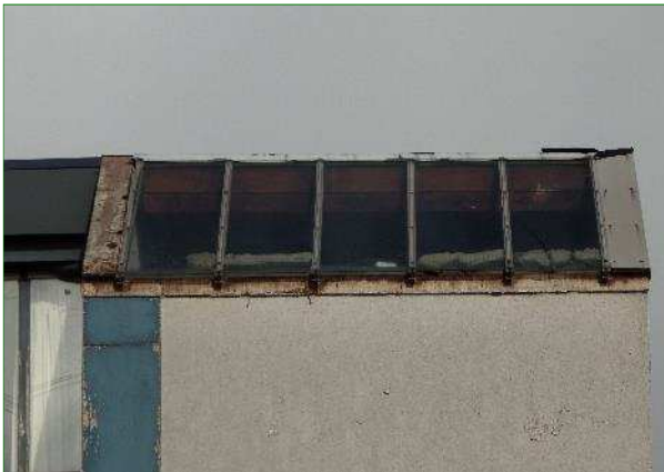
Het kleine gedeelte van de bebouwing met glazen dak, waarbij diverse openingen aanwezig zijn.
