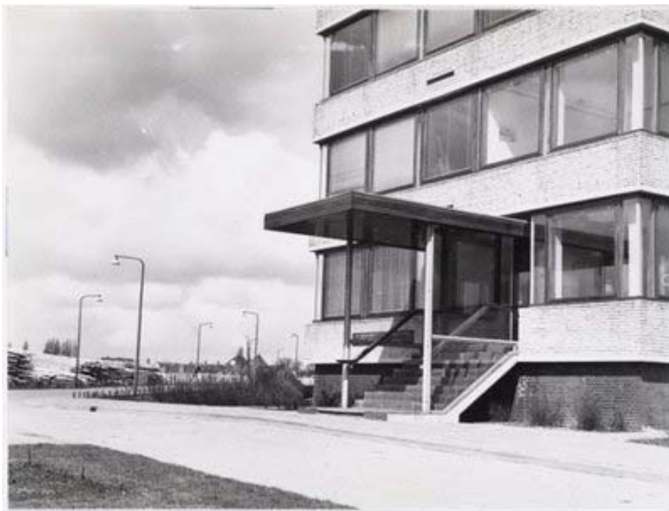
Oorspronkelijke entree van het kantoorgebouw, 1969
