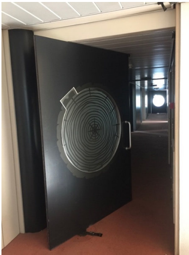
Taatsdeuren in de gangen, tuimelramen in de gevels
