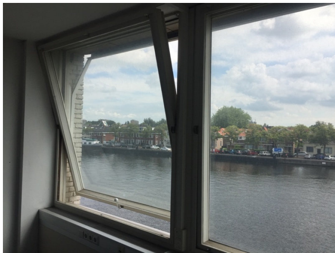
Taatsdeuren in de gangen, tuimelramen in de gevels
