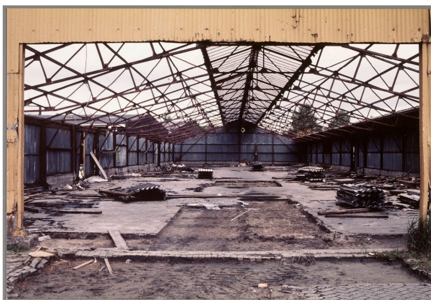
Sloop van de houtloodsen met stalen spanten, 1992
