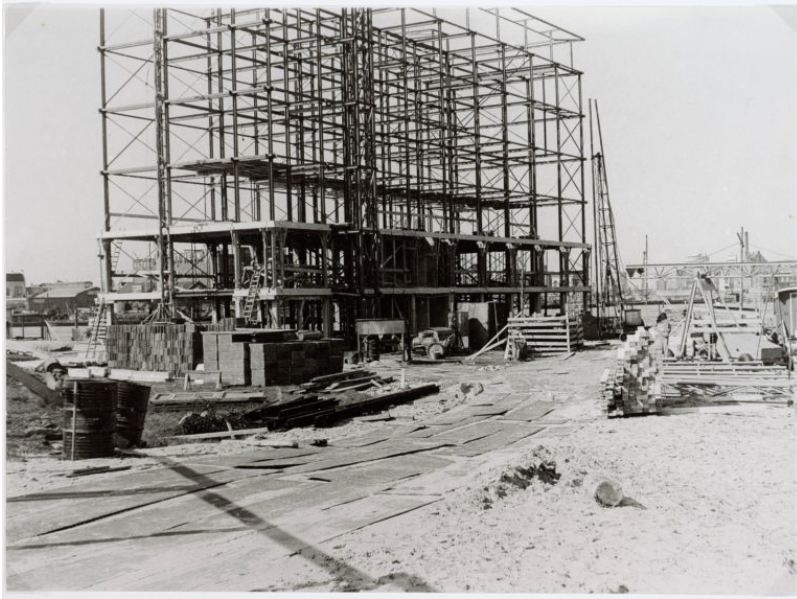
Bouw van staalskelet, 1963
