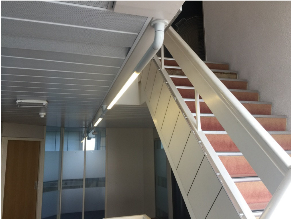
Interieur met systeemwanden en -plafonds, ingebouwde lichtarmaturen
