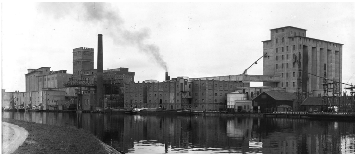
Nieuwe betonnen zaadsilo in 1920 naast de bakstenen oudere panden
