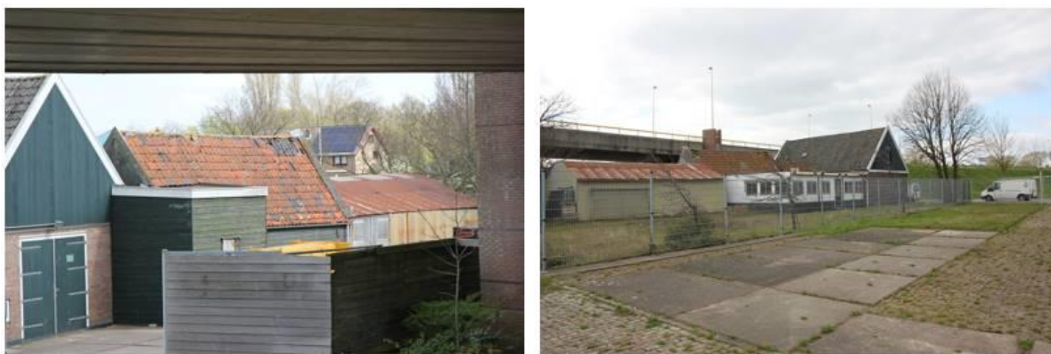
Figuur. 5.1 Bebouwing in het plangebied met losliggende dakpannen die kunnen fungeren als verblijfplaats voor gierzwaluwen.
