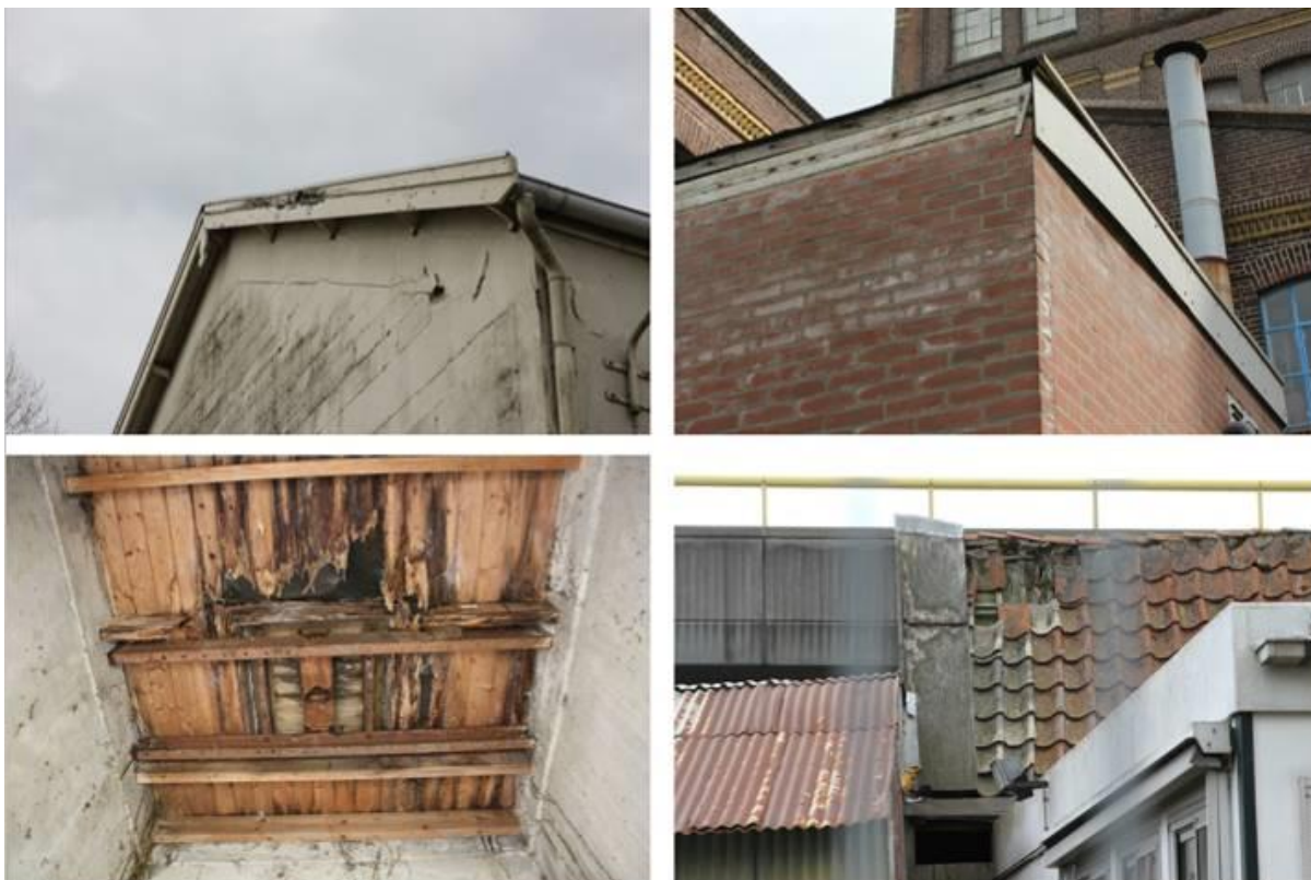
Figuur 5.3. Geschikte kieren en gaten in bouwwerken verspreid over het plangebied voor gebouwbewonende vleermuizen.
