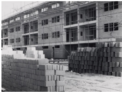
1962 Poelenburg in aanbouw (beeldbank Zaans archief 22.2097)
