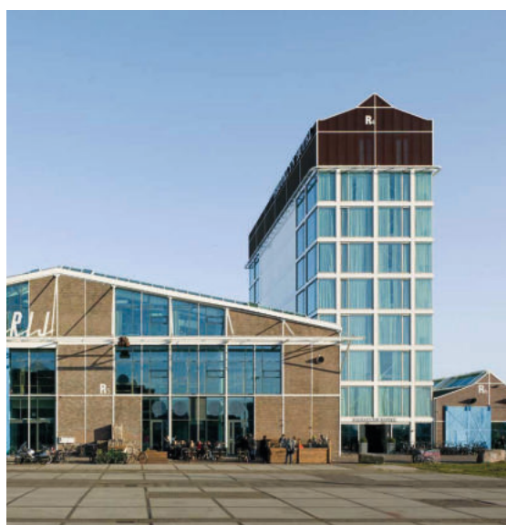
BESTAANDE LOODS ACHT VERDIEPINGEN OPGETILD
