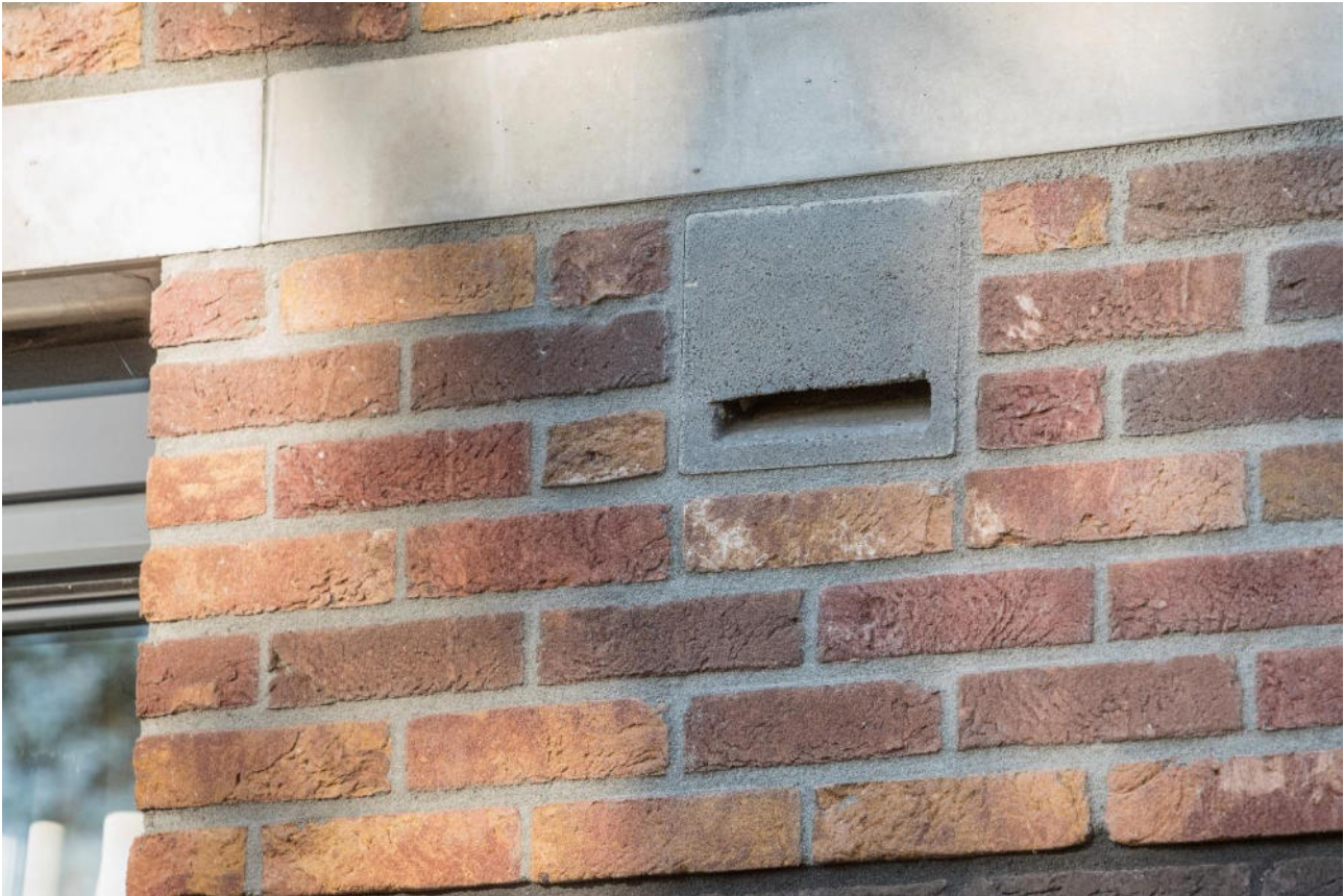
Figuur 10 Entresteen in een spouwmuur (Bron: Vivara)
