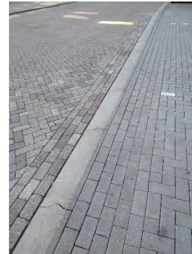
Foto 24: Verharding bij woonblok Oostzijde 273-285
