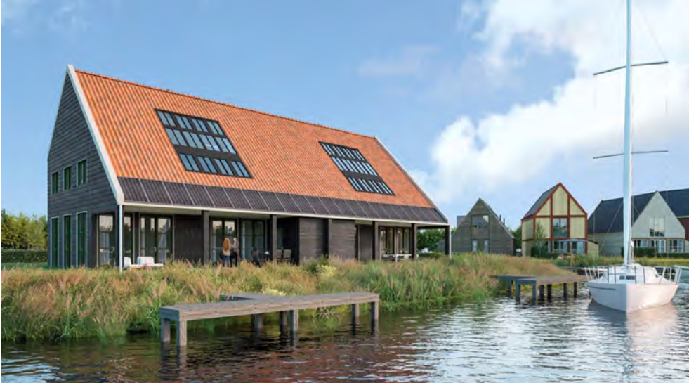
Referenties kleinschalige bebouwing, Zaanse Oever
