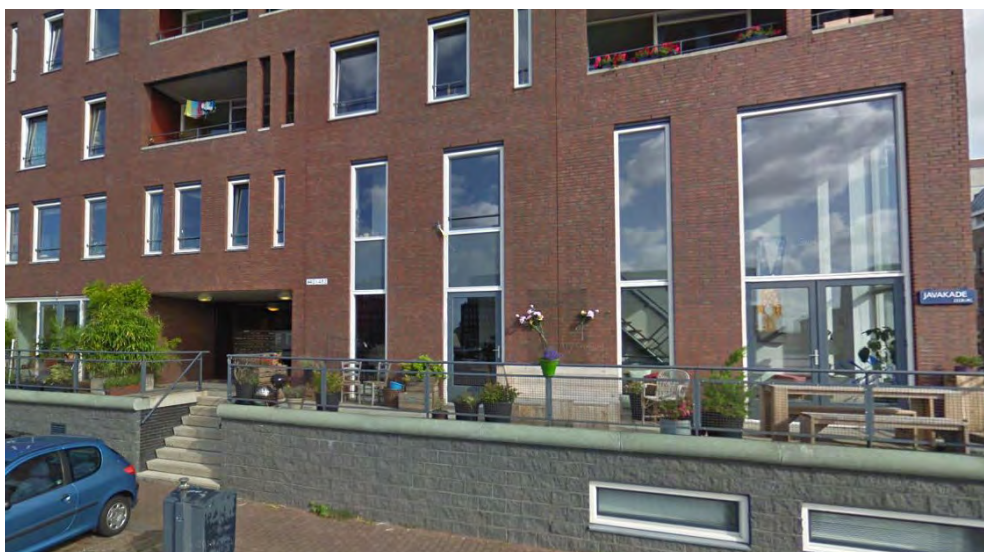
Buitenruimte als overgang privé openbaar
