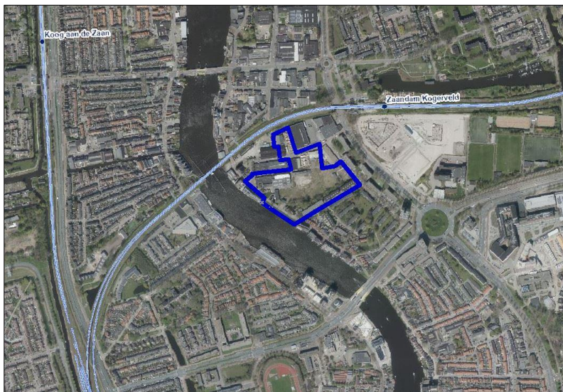
figuur 1: overzicht projectlocatie (huidige situatie)
