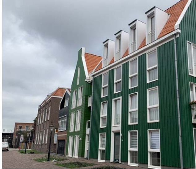
Afb. 4.8 Schuine daken voorzien van dakkapellen
