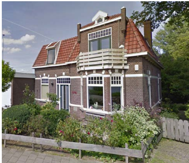
Afb. 4.31 Naburige bebouwing; op aan te sluiten in lint
