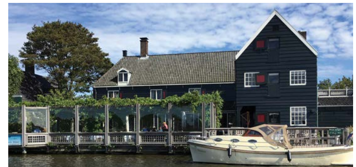
Afb. 4.34 Restaurant aan de Zaan
