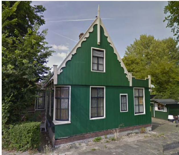
Afb. 4.30 Naburige bebouwing; op aan te sluiten in lint
