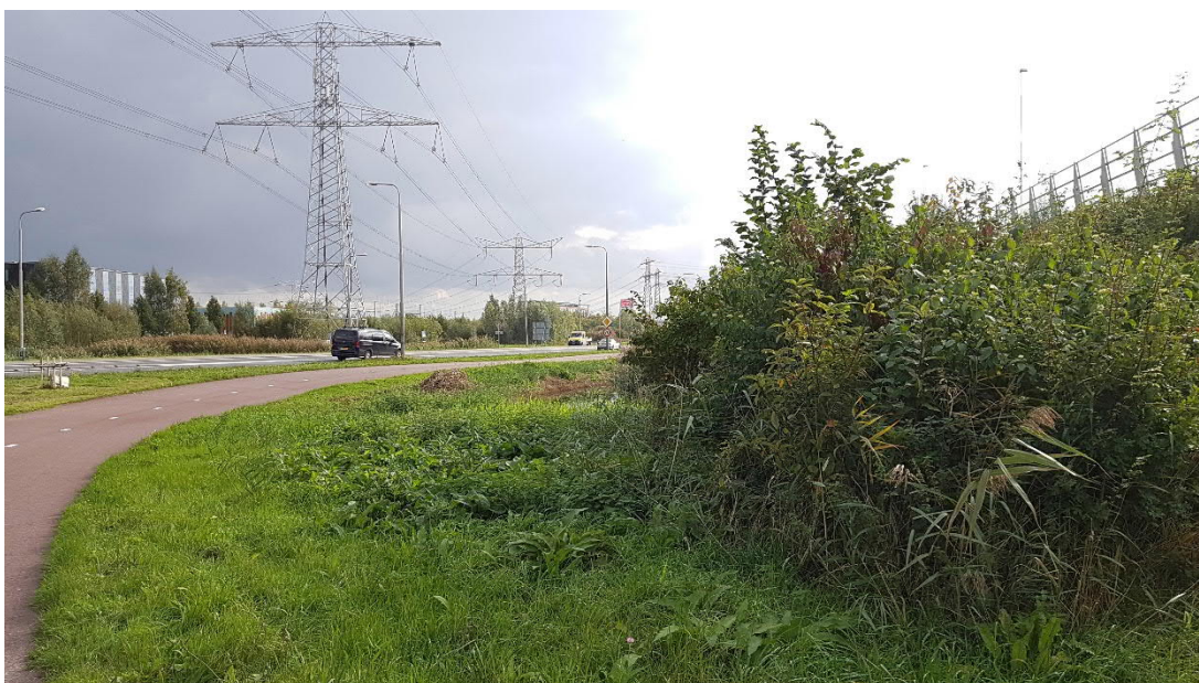
Figuur 3.1 Het oostelijke deel van het plangebied: het talud.
