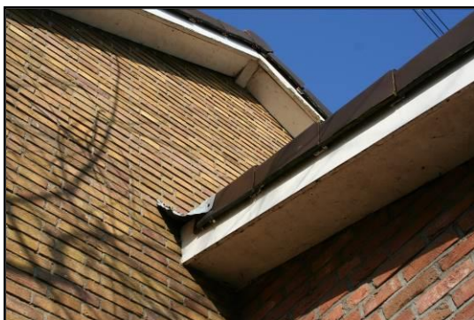
Afbeelding 5: Ruimtes onder loodflappen
