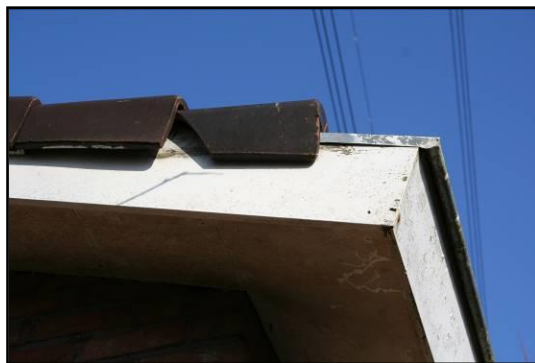
Afbeelding 4: Ruimtes onder dakpannen
