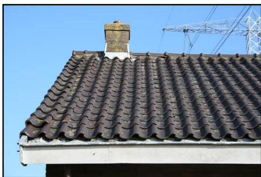
Afbeelding 9: Ruimtes onder de dakpannen
