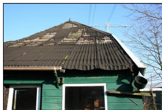
Afbeelding 6: Ruimtes onder dakplaten en dakranden
