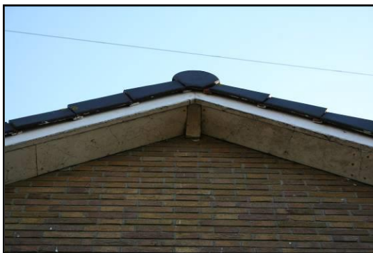
Afbeelding 3: Ruimtes onder dakranden en dakpannen
