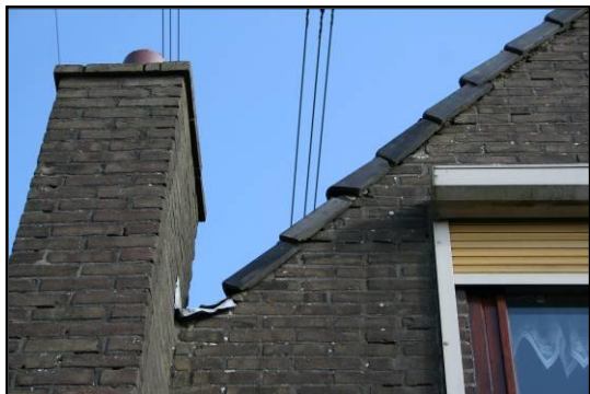
Afbeelding 3: Ruimtes onder dakpannen en loodflappen
