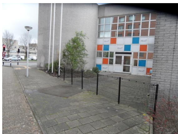
Foto 1: pand vanuit het zuiden gezien.
