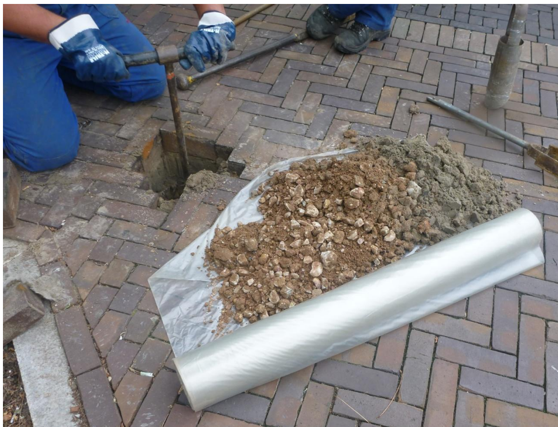
Fig. 3.1: Grove puinlaag ter plaatse van boring 2.
