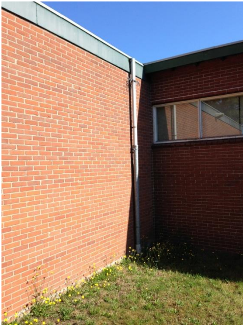
Figuur 7) Boeiborden wijken licht af van de muur.
