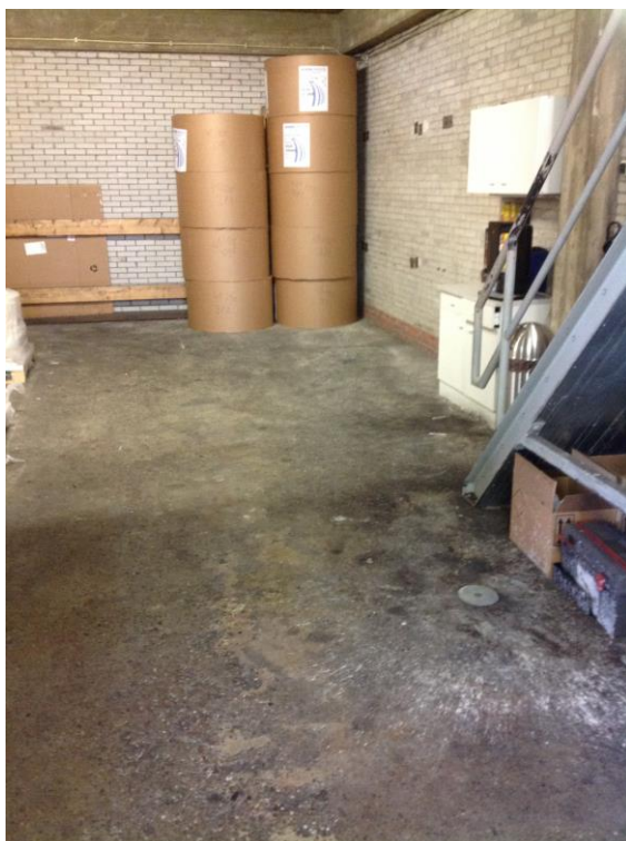
Foto 4: papieropslag 3 in noordelijke richting gezien
