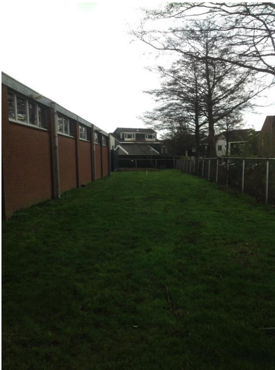
Foto 14: zuidzijde gebouw in oostelijke richting gezien
