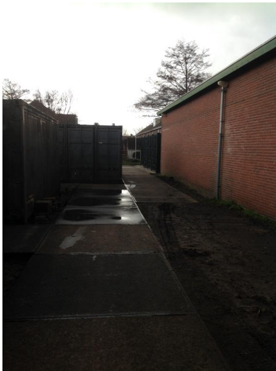
Foto 10: achterzijde gebouw in zuidelijke richting gezien
