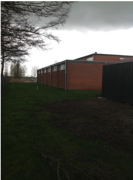
Foto 12: achterzijde gebouw in westelijke richting gezien
