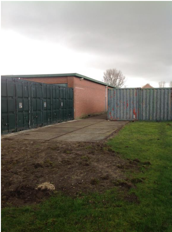
Foto 11: achterzijde gebouw in noordelijke richting gezien
