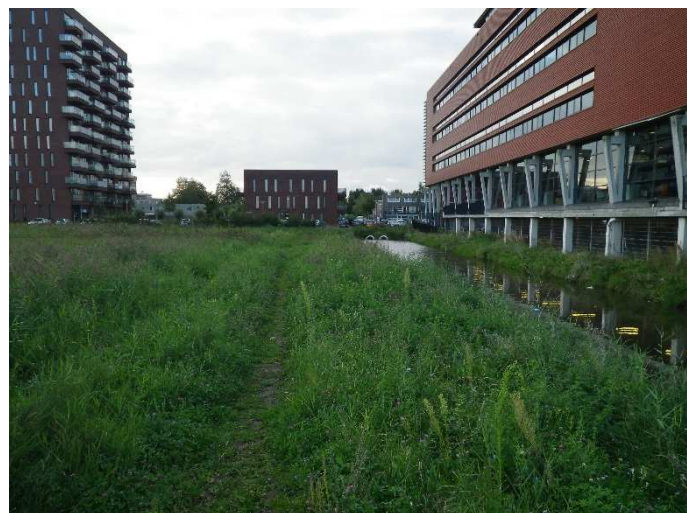
Figuur 1: Onderzoeklocatie, met halfverharding langs westelijke terreingrens, gezien vanuit het noorden in zuidelijke richting
