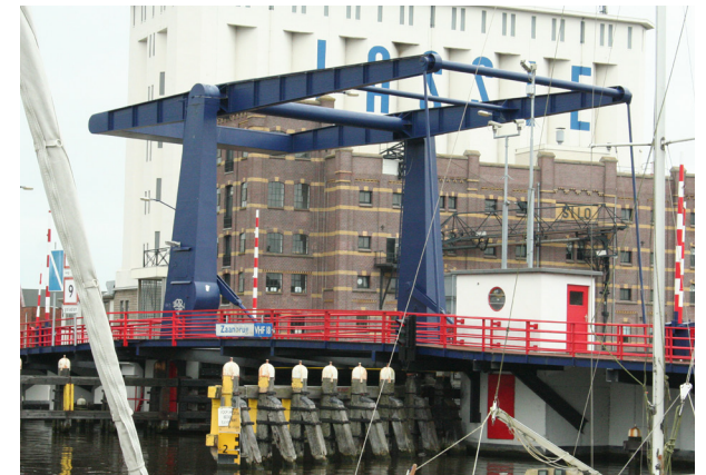
Huidige Zaanbrug, gebouwd in de jaren zestig
