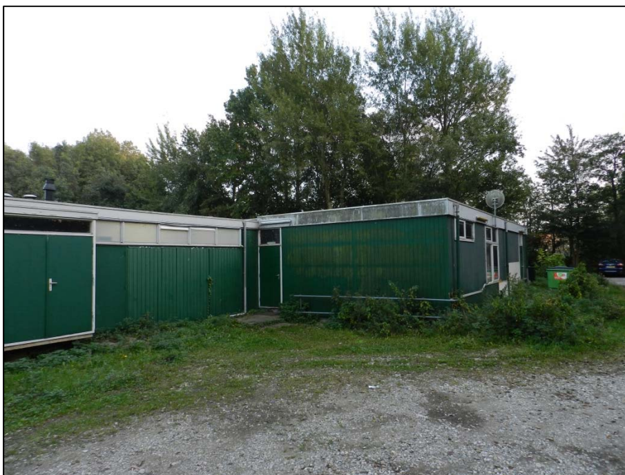
Achterzijde van de sportkantine. Een belangrijk deel van het onderzoek naar verblijfplaatsen van vleermuizen was gericht op aanwezige bebouwing in het plangebied.
