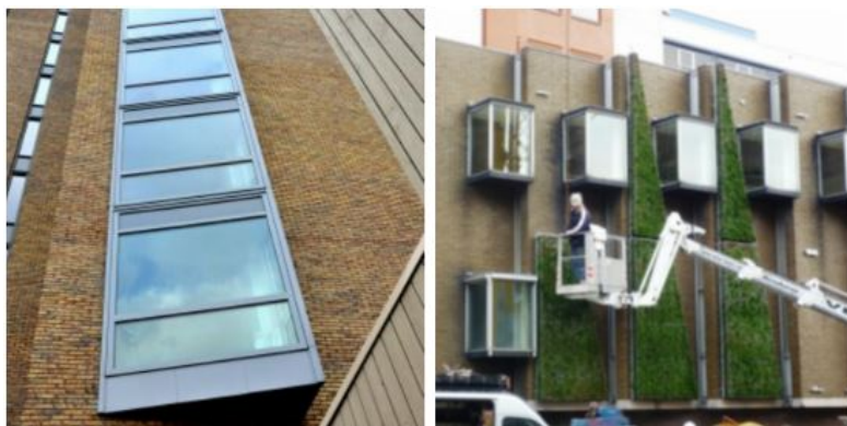
Figuur 7 Afscherming door uitgebouwde ramen waarmee een luwe zijde wordt gecreëerd.
