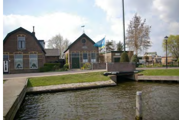
Gemaal Het Leven
