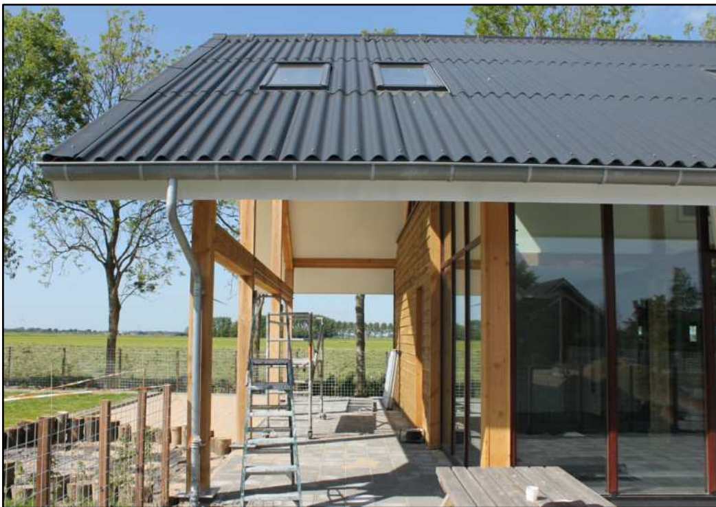
Figuur 9: foto bestaande veranda welke wordt dichtgemaakt
