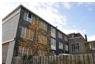
afb.7 Huidige situatie, achtergevel
