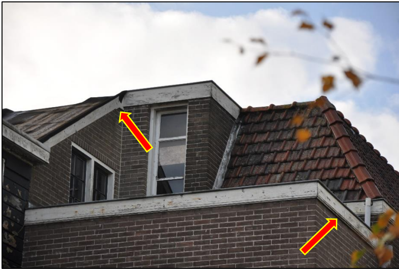
Afb 8: Diverse boeidelen met openingen aan onderzijde
