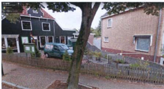
FOTO bestaande situatie
