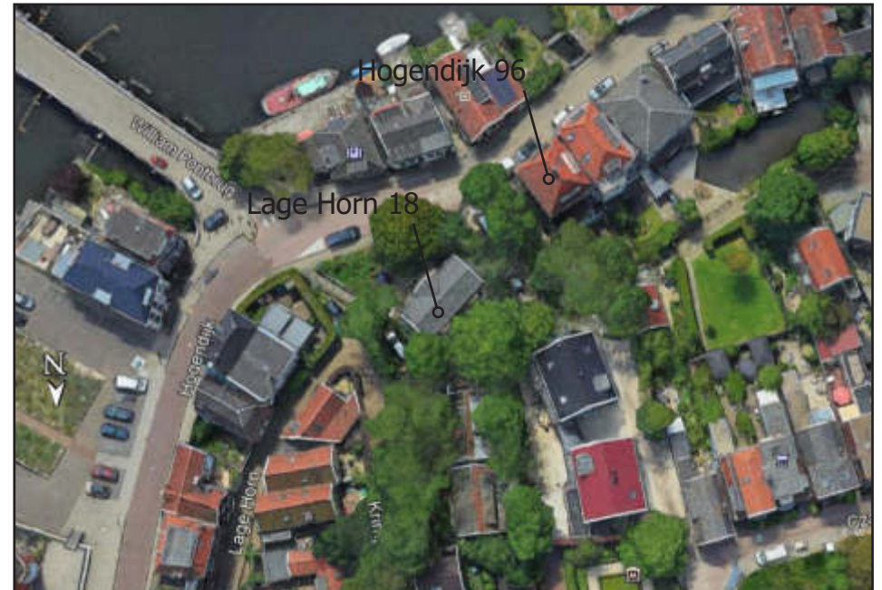
Afbeelding 2- Luchtfoto bestaande situatie, gezien vanaf de noordkant. Bron: Google Earth
