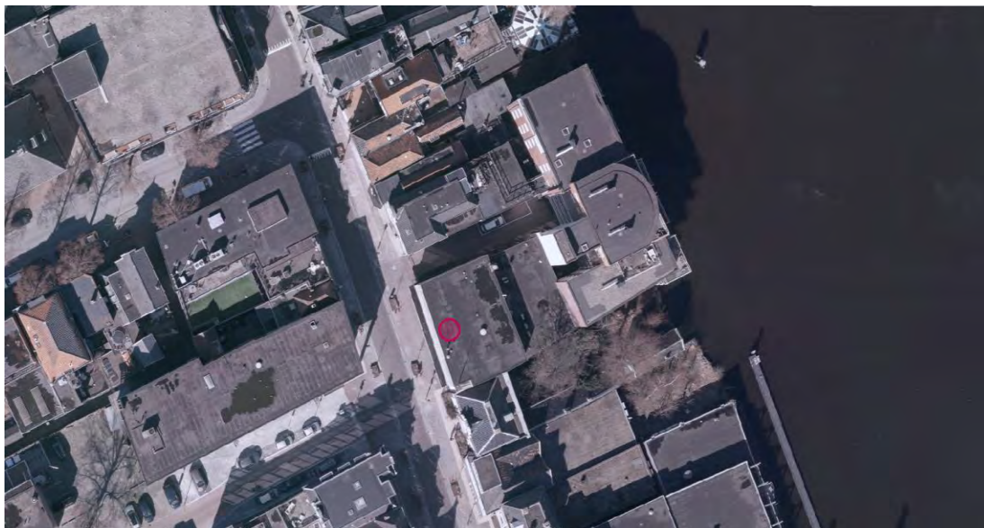
Afbeelding 5: luchtfoto huidige situatie Westzijde 40 te Zaandam
