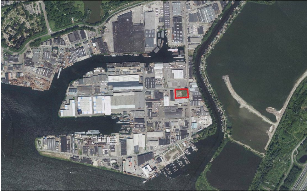
figuur 1. luchtfoto projectlocatie (bron: ruimtelijkeplannen.nl)
